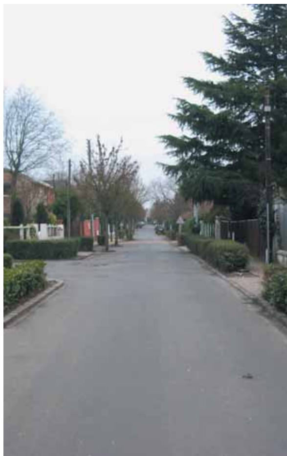
L'avenue du Panorama dans le quartier de Belleville va faire l'objet d'importants travaux dans le cadre d'un plan pluriannuel.
