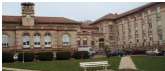
Centre médical de Bligny à Briis-sous-Forges.
