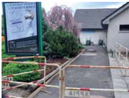
Les travaux aux abords du Club house.
