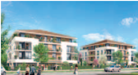
Façades côté rue des Goussons.
