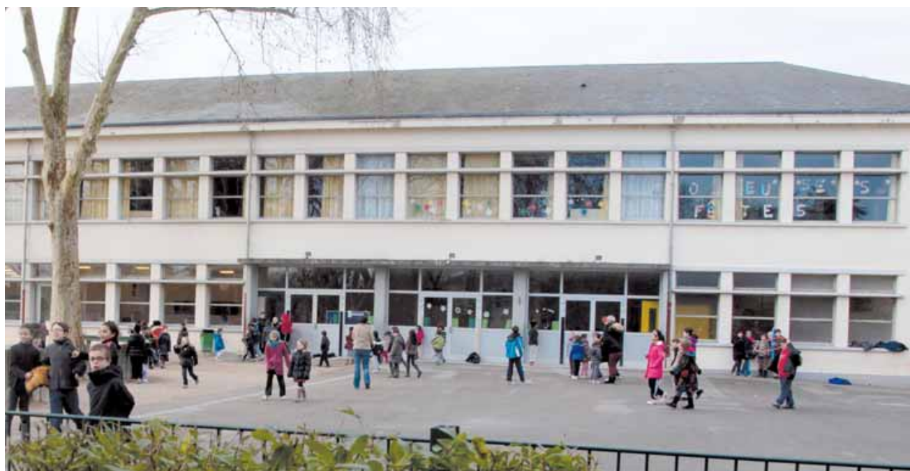
Les 250 fenêtres du groupe scolaire du Centre vont être remplacées en 2013.
