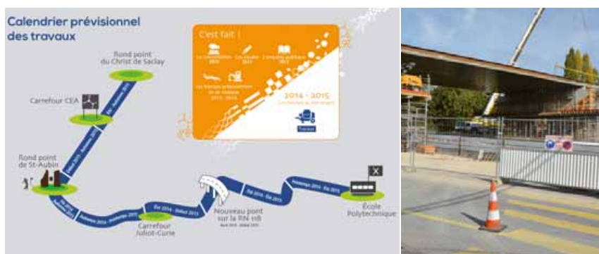
L'ouvrage d'art en cours de construction permettra au bus Express 91 06 de franchir la N118.
