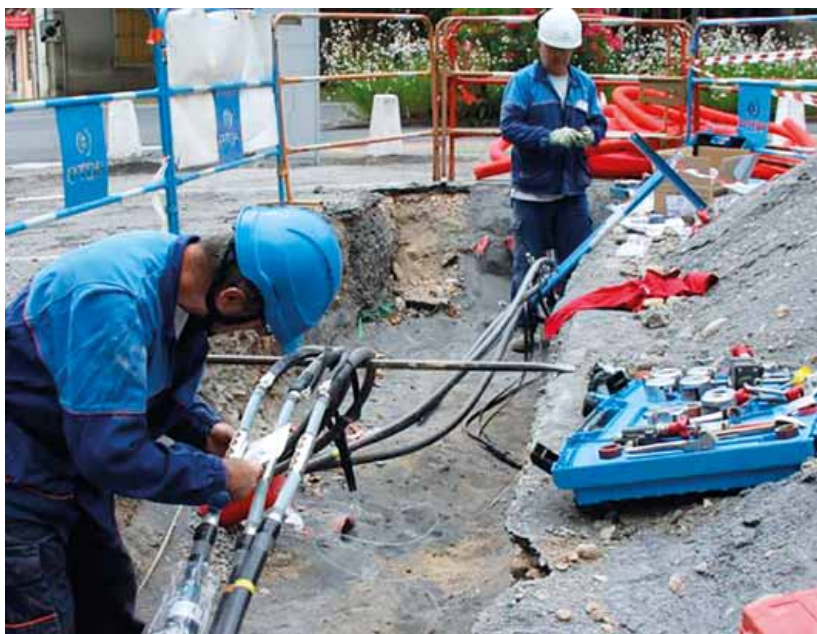
Opération de maintenance sur les réseaux électriques de Gif.
