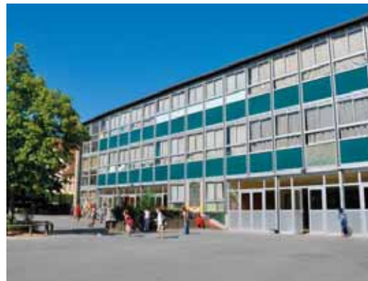
Des travaux de rénovation thermique seront menés à l'école élémentaire de Courcelle.
