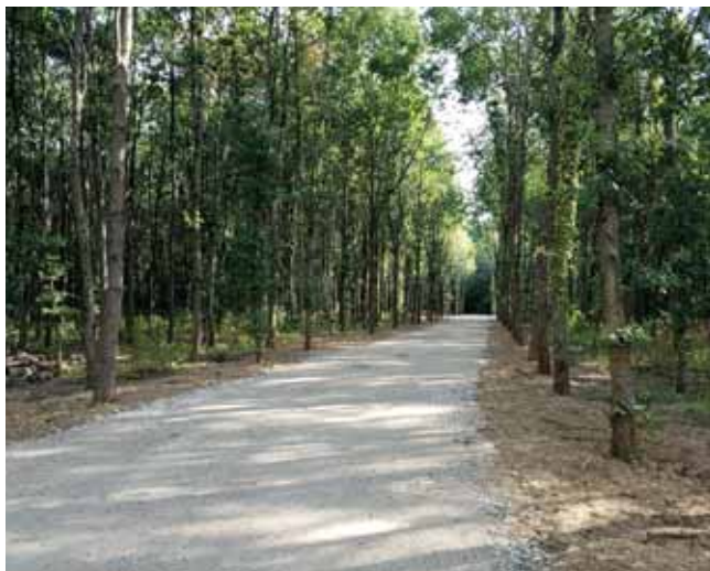
Cette route d'accès a été créée dans la partie Est du massif de la Hacquièrre pour permettre l'exploitation forestière.
