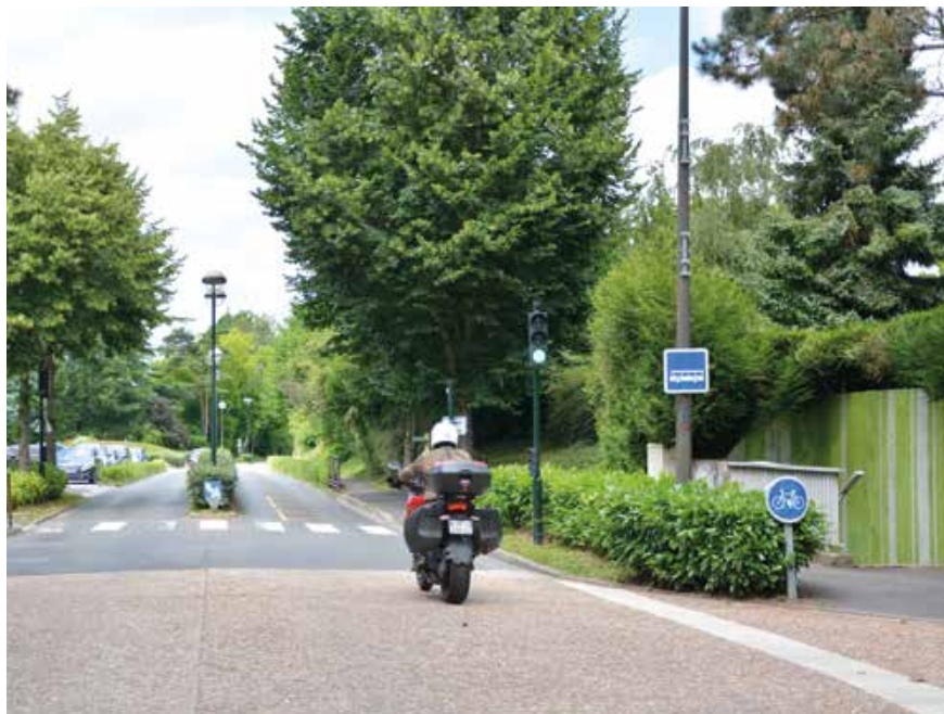
Dans le secteur des Neuveries, aux abords du groupe scolaire, différents aménagements routiers sont mis en place : ralentisseur, feu asservi à la vitesse, passage souterrain, plantations en milieu de voie, revêtement de la chaussée... Combinés les uns aux autres, ils sont destinés à préserver la sécurité des habitants
