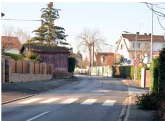
La rue de Madrid (Courcelle) fait partie des voies dont la réfection est prévue cette année.
