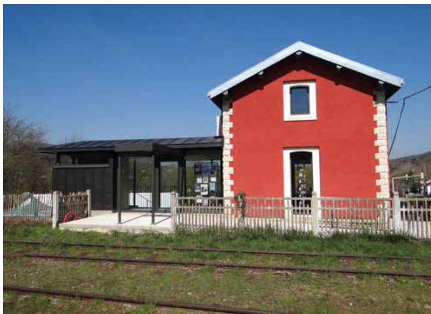
L'ancienne maison du garde-barrière a été réaménagée pour donner naissance à l'Aiguillage.
