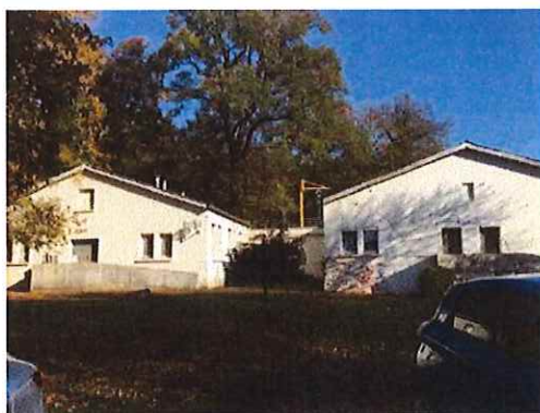
Bâtiments du CNRS – source : atopia
